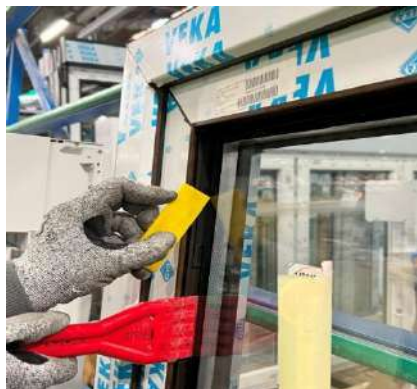
Colocación de calces
